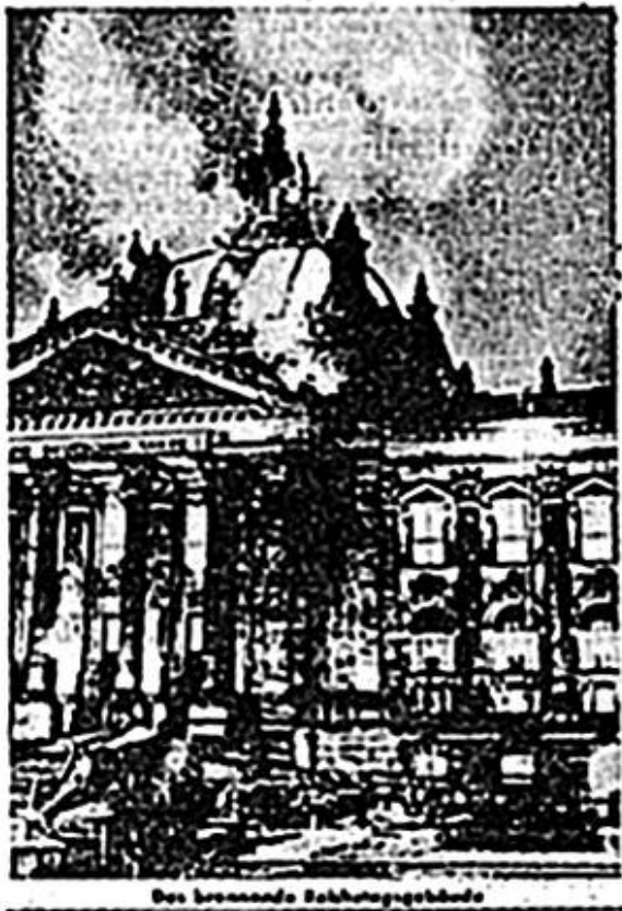
Das brennende Reichstagsgebäude
